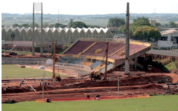
Resistente ferrão do fundo durante as obras de modernização da Fonte Luminosa
